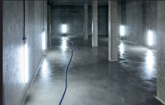
Wasserkammer während Unterhaltsarbeiten
